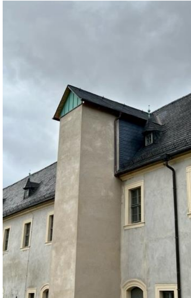
Aufzug nach Fertigstellung
